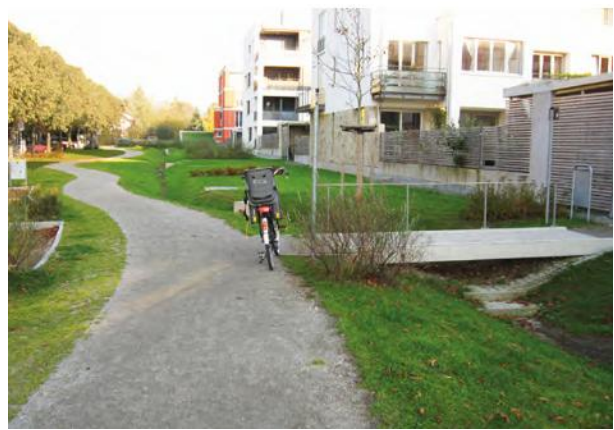
Abbildung 41) Beispiel eines unversiegelten Geh- und Radwegs in Freiburg, Wiehre (Material: Splitt) (Quelle: Umweltschutzamt Freiburg)
