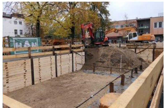
Abbildung 31) Aufnahme der unterirdischen Rigole vor Auffüllung mit Kunststoffkästen und Verkleidung durch ein Geotextil (Quelle: BG 2022)
