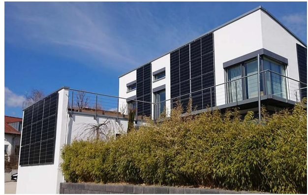
Abbildung 19) 2010 erbautes Passivhaus mit Wärmepumpe und Solaranlage. (Quelle: E3/D3 HagerEnergy GmbH)
