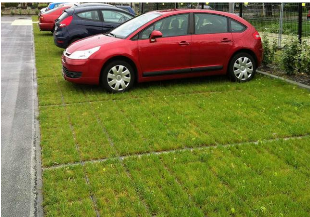
Abbildung 42) Entseiegelung durch Rasengittersteine (Quelle: Hübner-Lee GmbH & Co. KG)
