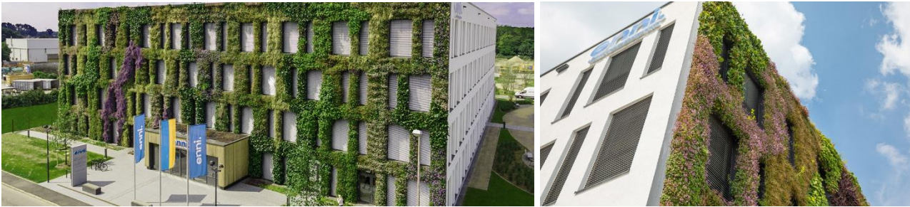
Abbildung 21) Fassadenbegrünung ENNI Moers. (Quelle: EJOT SE & Co. KG)
