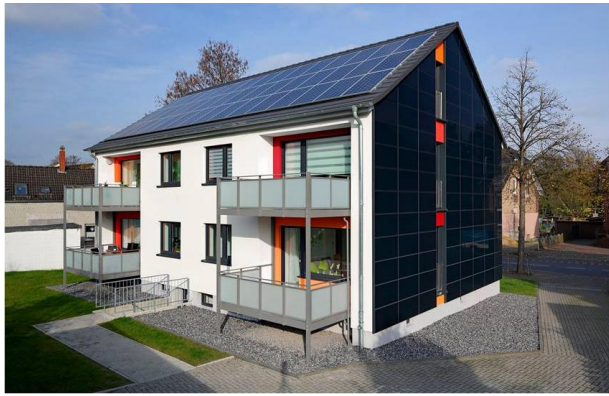
Abbildung 20) 1960er-Jahre Wohnhaus mit 170 Photovoltaik-Modulen an der Fassade und 90 Photovoltaik-Modulen auf dem Dach. (Quelle: Vivawest GmbH)
