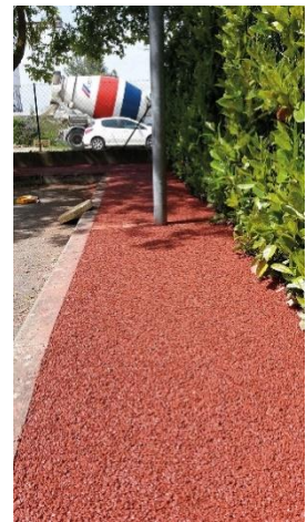
Abbildung 45) Fahrradweg aus Dränbeton. (Quelle: Kommunaldirekt 2021, Foto: CEMEX)
